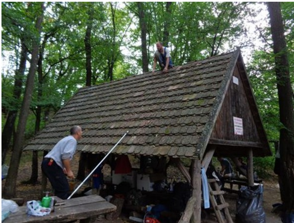
7. kép: Tetőjavítás közben
