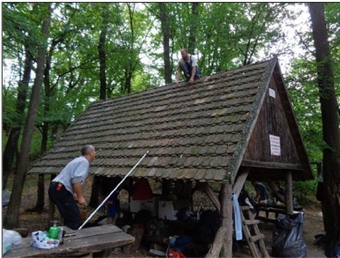
7. kép: Tetőjavítás közben
