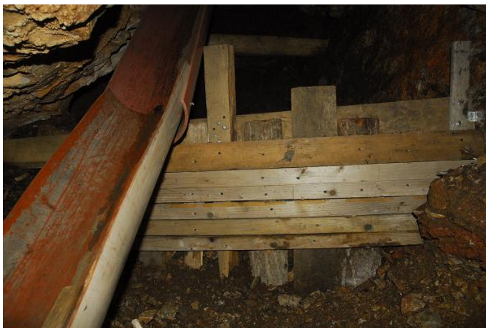
A megerősített alsó depónia
