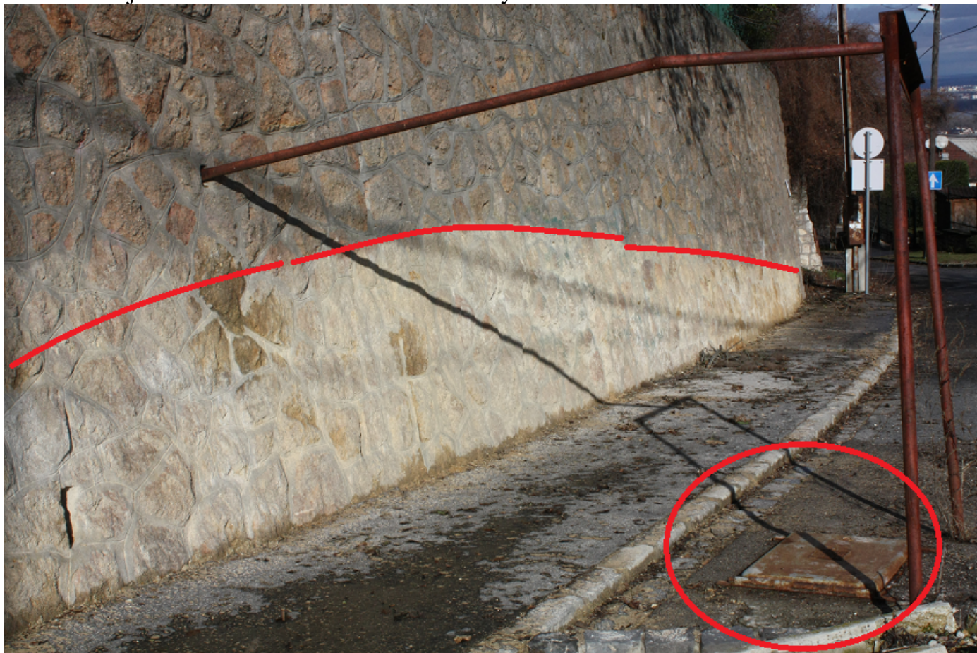
A képen bekarikázva a barlang bejárata, a támfalon jelölve a törmelék szintje.
