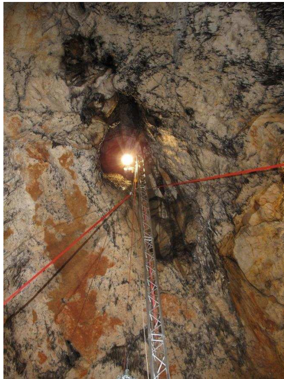
A ferde szakasz rögzítése az oszlop tetején
