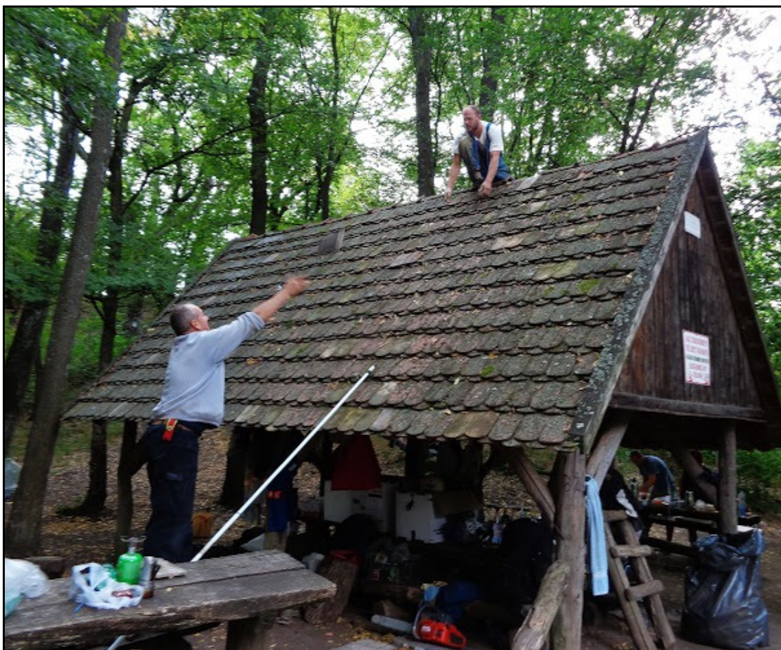
25. fotó. Az esőbeálló cserepeinek helyreállítása (Harangozó Attiláné)
