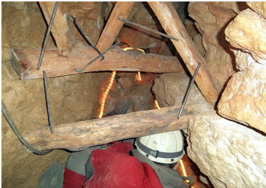
6. sz. fotó: A jelenlegi végponton folyó kutatások biztonsága érdekében vörösfenyőből készült ideiglenes ácsolatot építettünk be (fotó: Molnár Balázs)
