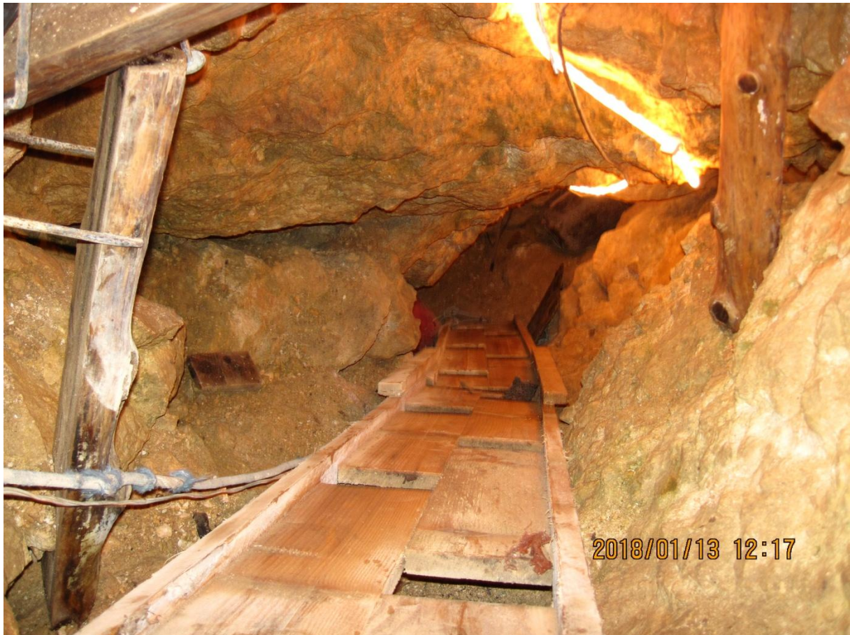
7. sz. fotó: A reményt adó, több részletben feltárt, nagyméretű kövekkel eltömődött 8m hosszúságú és 6,5 m mélységű lejtős akna, melynek bal alsó végében huzat irányában haladunk a műút irányában. A fényképen az akna bejáratába épített, vörösfenyő ácsolat és a mozgatható csúszdás-létra látható (fotó: kocsis János)
