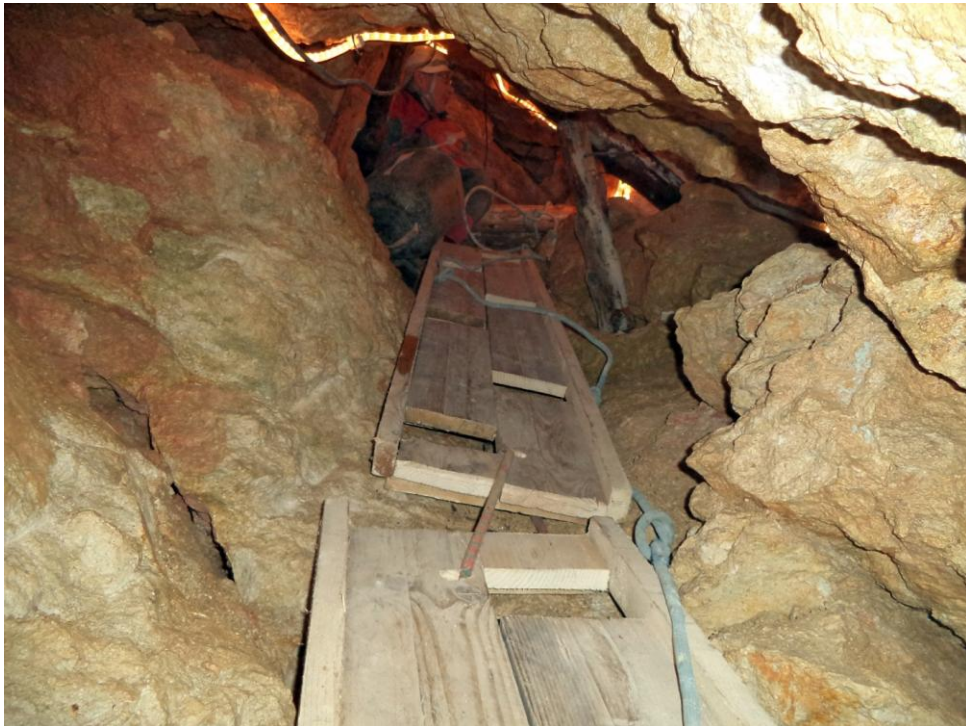
5. sz. fotó: A barlang 2016-ban, több részletben feltárt kisaknájában történő biztonságos mozgás érdekében gyorsan telepíthető, összecsuksukható csúszdás-létrát használtunk, melyet műszak végén könnyedén tudtunk kiszállítani a barlangból
