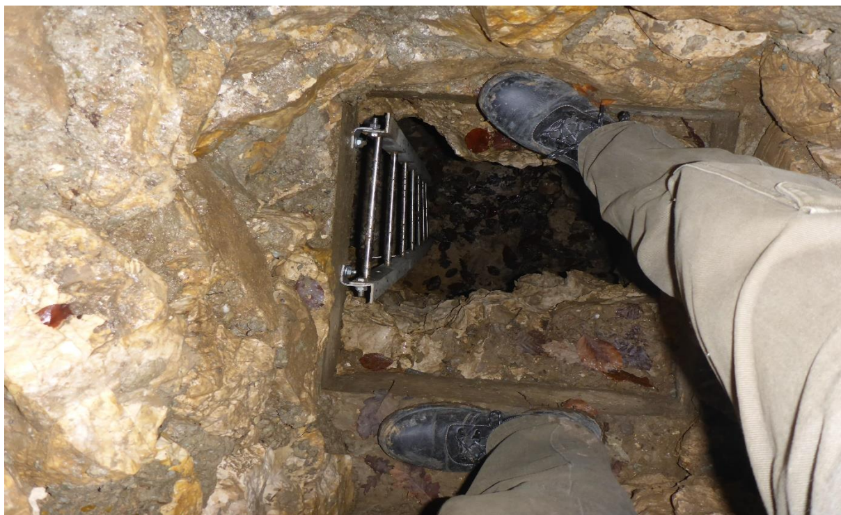
91. kép Létra a bejáratú akna alsó részén.
