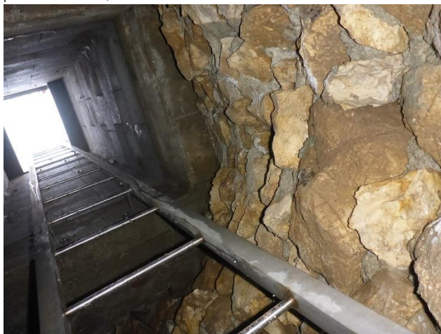
52. kép A Benzinkút-barlang bejárata alulról.
