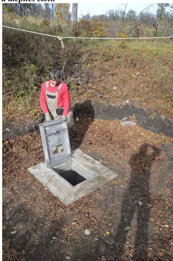
120. kép És a kiépítés után.
