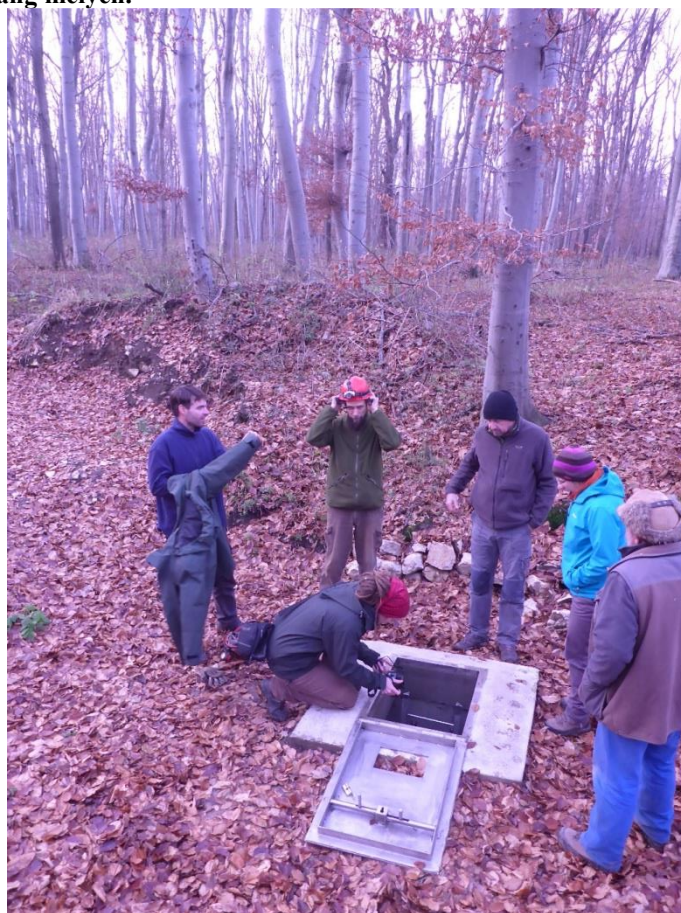
115. kép A kiépítést követő átvevő bizottság. (a kiépítést 4-en csináltuk...)
