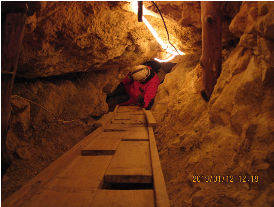
19. ábra: a „forduló” a legkeményebb munkahely: itt kell átemelni a végpontról érkező badellákat a 70°-os lejtésű „nagyakna” csúszdájára. Persze mindezt kényelmetlen testhelyzetben, kicsi helyen... (fotó: Stieber József)
