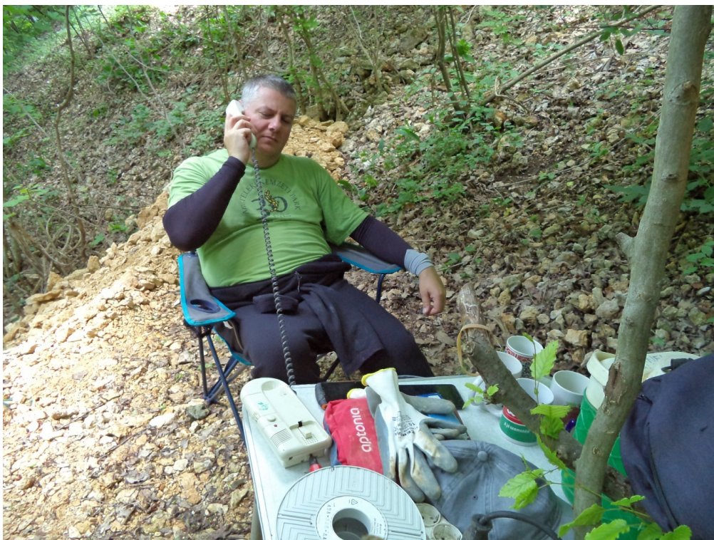
21. sz. fotó: a felszín és a bontási végpont között ideiglenes telefonösszeköttetést létesítünk, minden egyes bontási alkalommal, a biztonság érdekében. (fotó: Kocsis Gergely)
