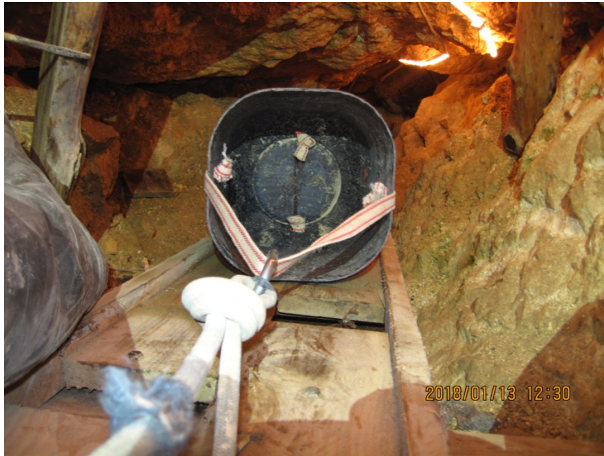
11. sz. fotó: Anyagmozgatás az ideiglenesen beépített, vörösfenyőből készült csúszdán. (Fotó: Stieber József)
