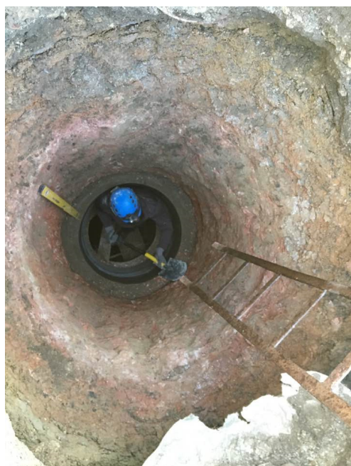
A kútgyűrűsor betonalapja
