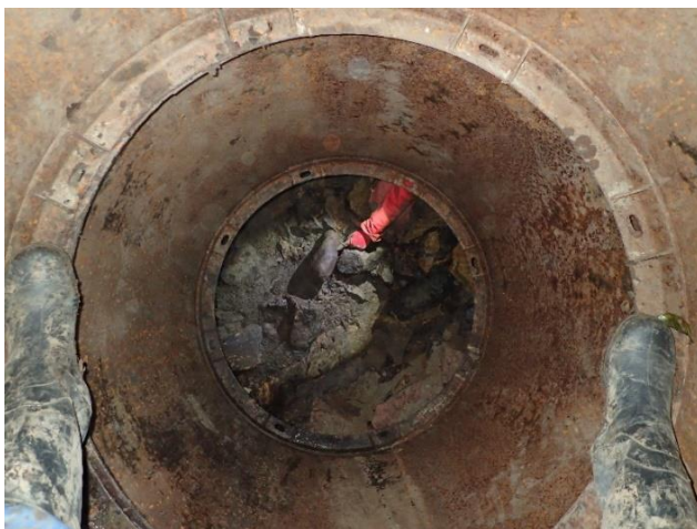
A Gubacsos-bg. nyelőjében kialakított bejáratú akna
