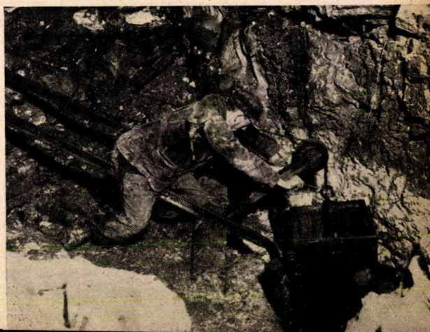
A buktatócsiga felemelésével a szerző bebuktatja a vedret az álfenékbe süllyesztett aknába. A képen látható, hogy a drótkötél a bal hónalj alatt fekszik s a csiga vissza-
