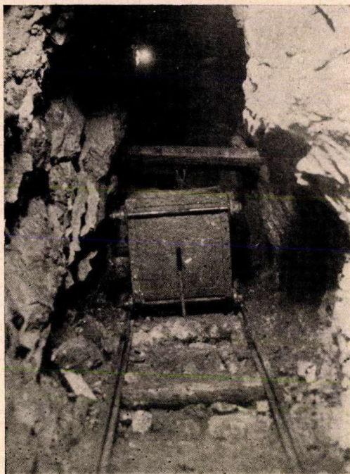
A görgővel ellátott járomfához ért veder a talpába dugott vascővekkel ki van támasztva. A járomfa elfordítása után a veder függőlegesen folytatja útját. A szerző felvétele
