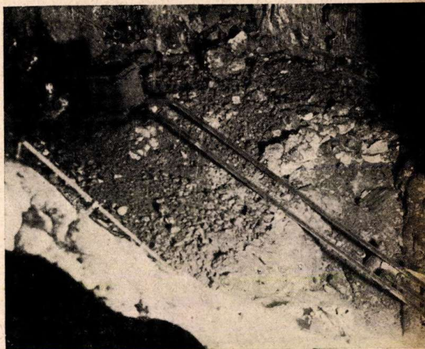
A Kiskőháti cseppkőbarlang II. szintjének a feltáráshoz az alsózomboly álfenékén. 113 m mélységben van felállítva a készülék. Balra a csőrlő, előtte a veder s az aknába hajló sín pár közt csukott állapotban a buktató csiga. A szerző felvétele
