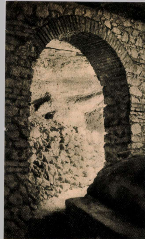
A kórház alapfalainak alátámasztása a barlangban
