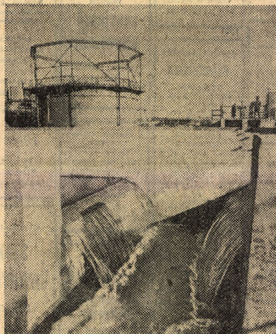
A PÉCSI SZENNYVÍZTISZTÍTÓ TELEP kipróbálását kezdték. Az új telep mintegy 20—22 ezer köbméter vizet tisztít meg kémiai és mechanikai úton és javítja a város vízellátását. A képen: az elfolyó, vagyis a megtisztított víz
