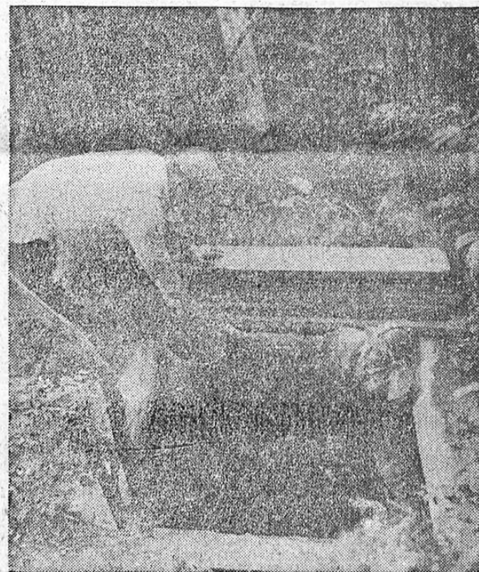
A kutató aknából vödörrel „küldik ki” a kitermelt anyagot.
