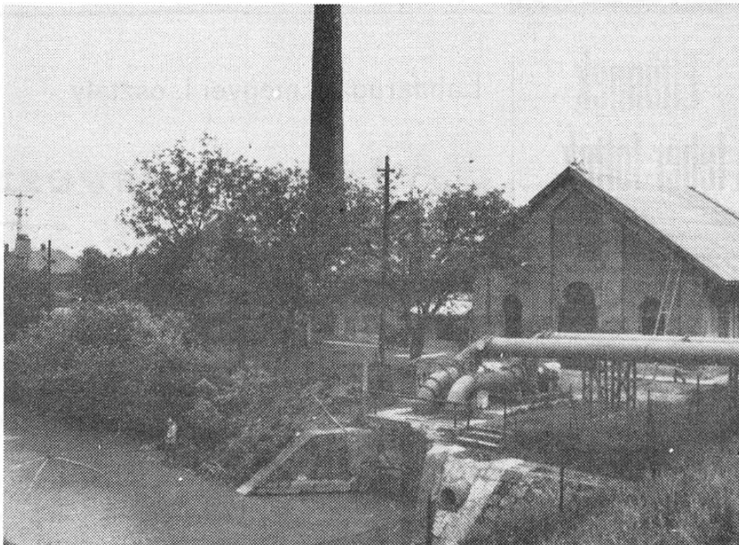
A szivattyútelepek több mint egymillió köbméter vizet emeltek át a tározókba
