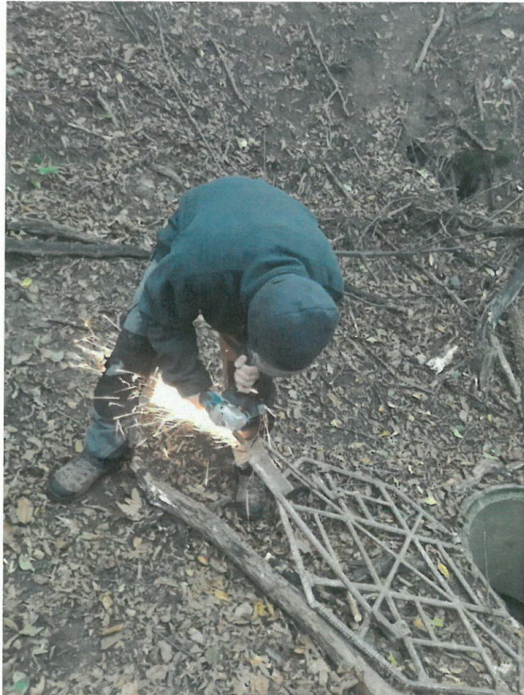
Régi zárszerkezet eltávolítása a bejáratról
