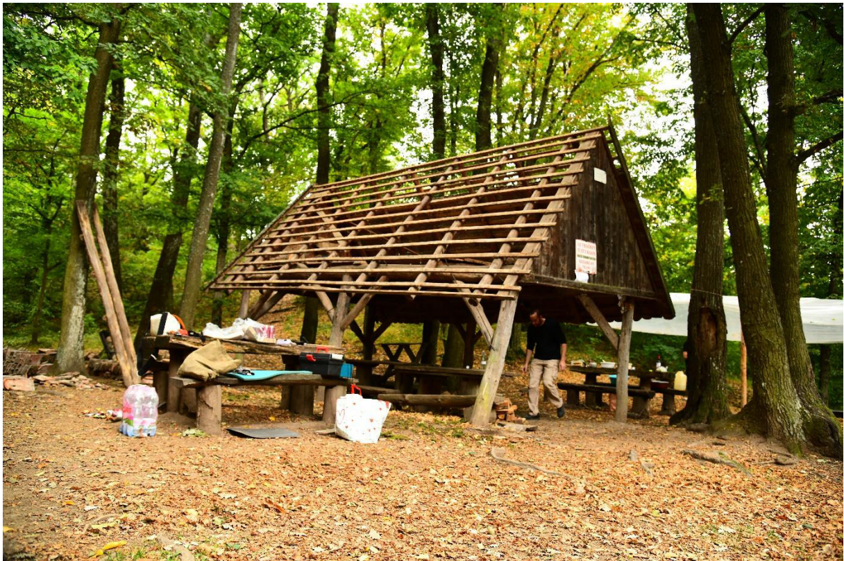
A felvételen látható, hogy a tartóoszlopok milyen mértékben dőltek meg /Fotó Kántor Andrea/
