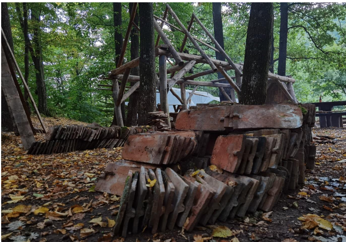
A cserepeket ép állapotukban szedtük le, hogy vissza lehessen rakni az új épületre /Fotó Kaposvári Kazimír/
