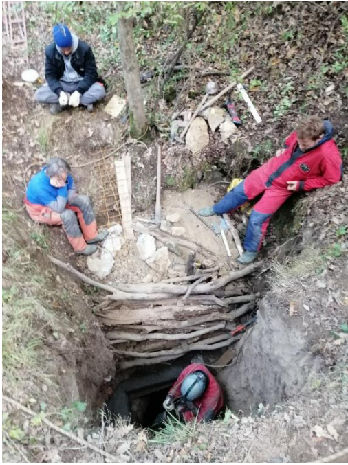
Az új lejárati akna a készülő betonalappal, mögötte a feltöltött régi kutatóakna A képen Mészárosné Hardi Ágnes, Kiss Gergely, Szepesi Viktor, Kudlik Dávid (lenn) (Fotó: Szilaj Rezső)
