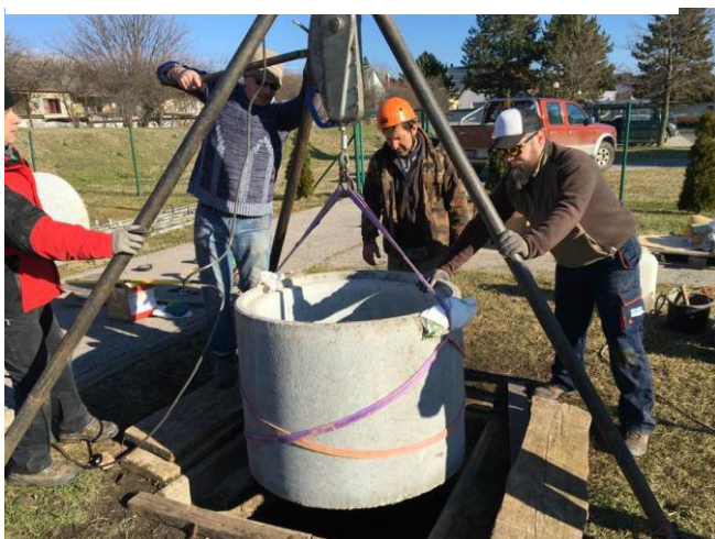
A kútgyűrűk behelyezése (Meiczinger Máté, Szilaj Rezső, Horváth Sándor, Végh Attila)
