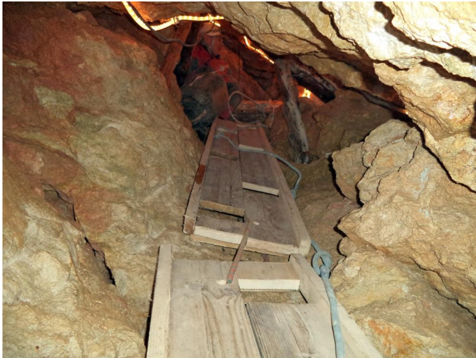
1. sz. fotó: A barlang 2016-ban, több részletben feltárt kisaknájában történő biztonságos mozgás érdekében gyorsan telepíthető, összecsuksukható csúszdás-létrát használtunk, melyet műszak végén könnyedén tudtunk kiszállítani a barlangból (fotó: Kocsis Gergely)
