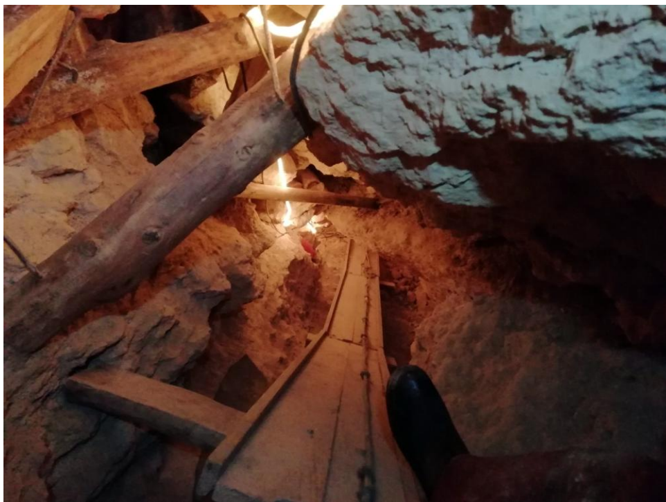
14. ábra: a végpont felé tartó kb. 30°-os lejtésű, mára már 12 méter hosszúságú, 1 méter magas járat, benne vörösfenyőből készült csúszdával, a badellák könnyebb mozgatására (fotó. Sztratiev Balázs)
