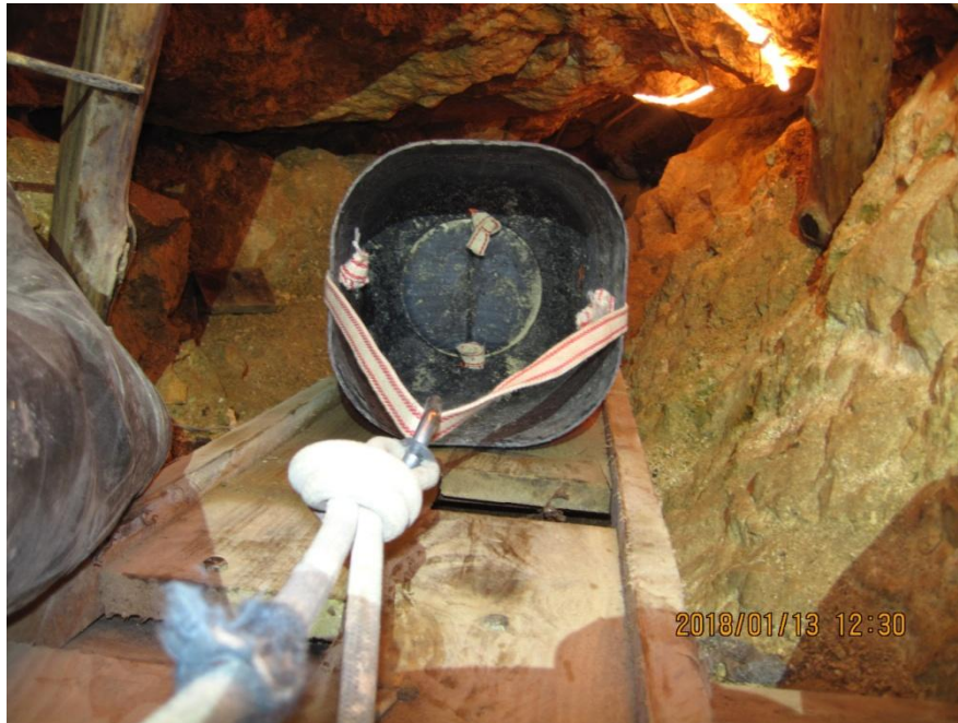
7. sz. fotó: Anyagmozgatás az ideiglenesen beépített, vörösfenyőből készült csúszdán. (Fotó: Stieber József)
