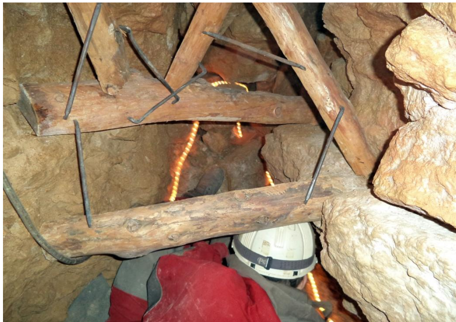
2. sz. fotó: A jelenlegi végponton folyó kutatások biztonsága érdekében vörösfenyőből készült ideiglenes ácsolatot építettünk be (fotó: Molnár Balázs)
