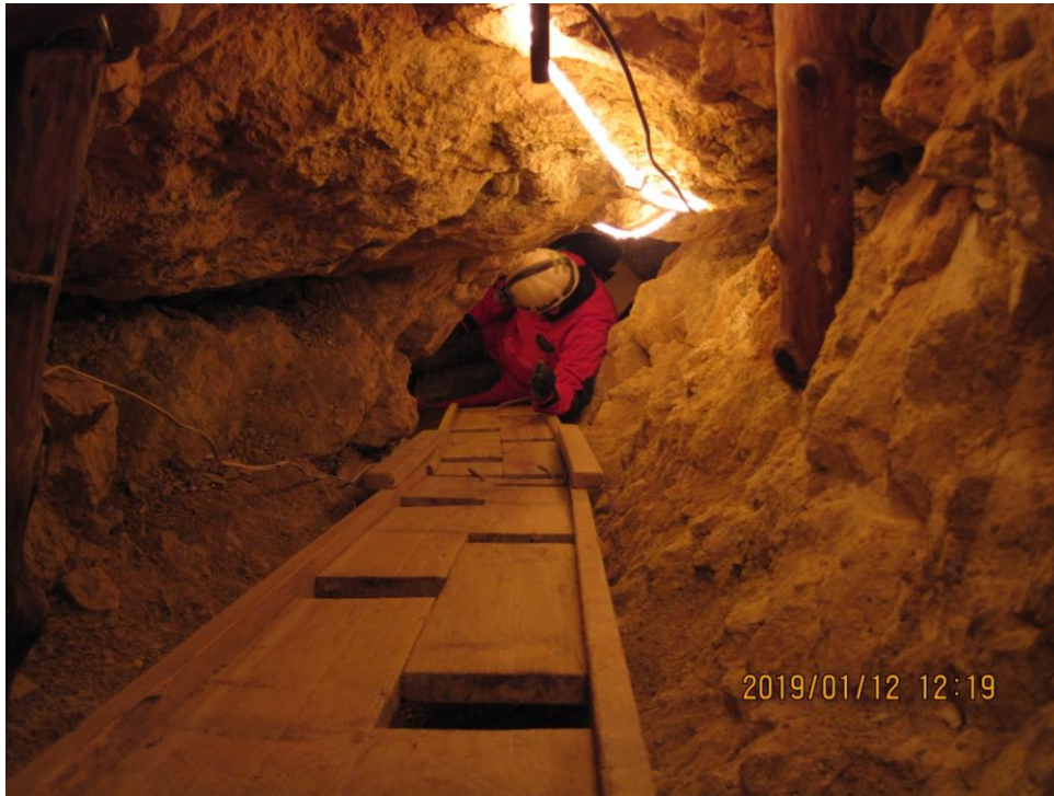
13. ábra: a „forduló” a legkeményebb munkahely: itt kell átemelni a végpontról érkező badellákat a 70°-os lejtésű „nagyakna” csúszdájára. Persze mindezt kényelmetlen testhelyzetben, kicsi helyen... (fotó: Stieber József)
