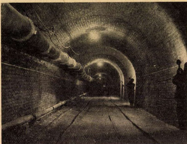
4. ábra. A villányi alagút elkészült téglafalazatú szakasza
