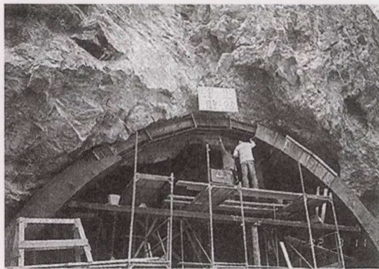
7. ábra. Folyik az ív bebetonozása
