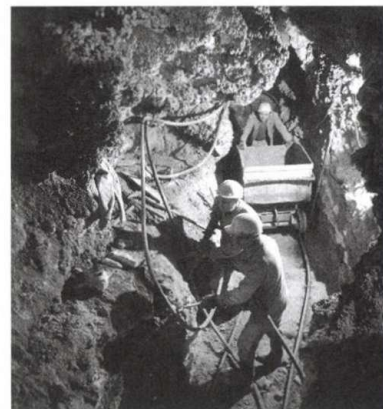
5. ábra: Áttöréskészítés kézi munkával a látogatható szakasz kiképzése idején
