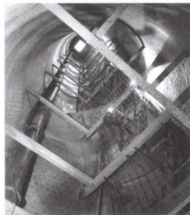
4. ábra: A lemélyített függőleges akna szerelvénye
