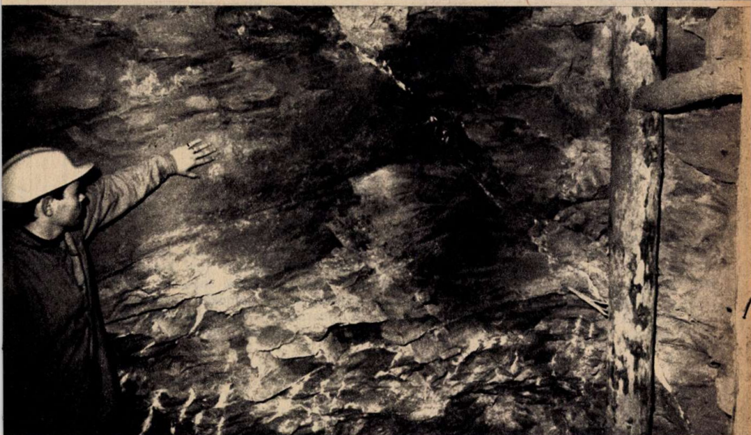
Törésvonal mentén elmozdult budai márga-rétegek a Metró Batthyány tér–Déli vasút állomások közötti szakaszán
