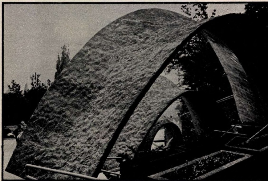
A Lepence-völgyi strand egyik medencéjét vasbeton ívek árnékolják
