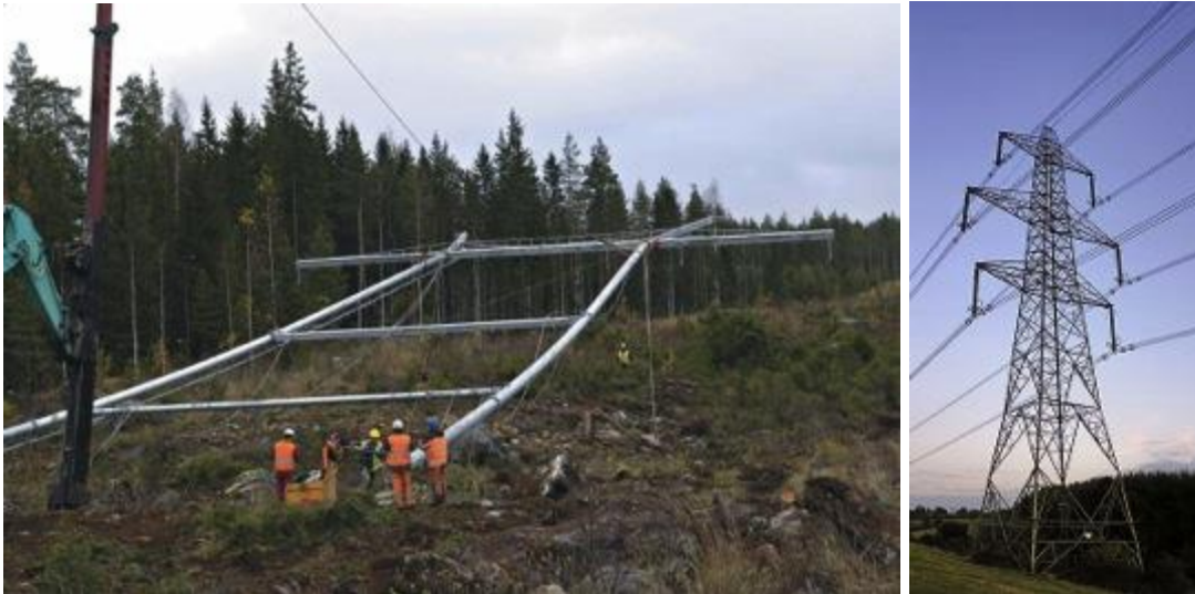
Fotó (bal oldal): légvezeték telepítése, Hill of Aldie, UK © Anne Burgess, Creative Commons, Fotó (jobb oldal): azonos feszültségű kettős vezeték, négyes kötegvezetével © yumifruitbat, Creative Commons.
