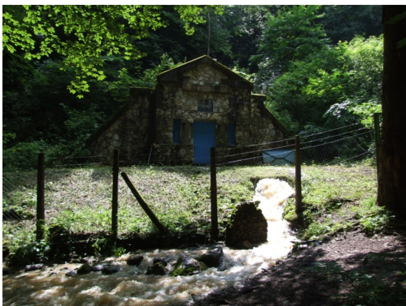
5.ábra. A Felső-forrás árvízkor (Fotó: SÁSDI L.)
