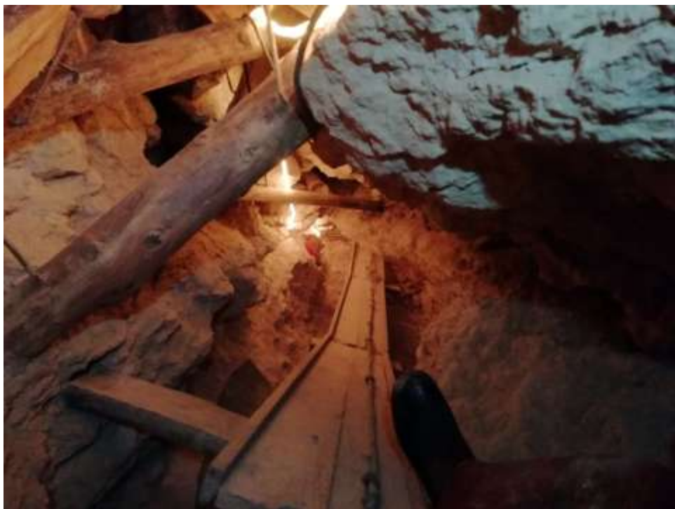
13. ábra: a végpont felé tartó kb. 30°-os lejtésű, mára már 12 méter hosszúságú, 1 méter magas járat, benne vörösfenyőből készült csúszdával, a badellák könnyebb mozgatására (fotó. Sztratiev Balázs)
