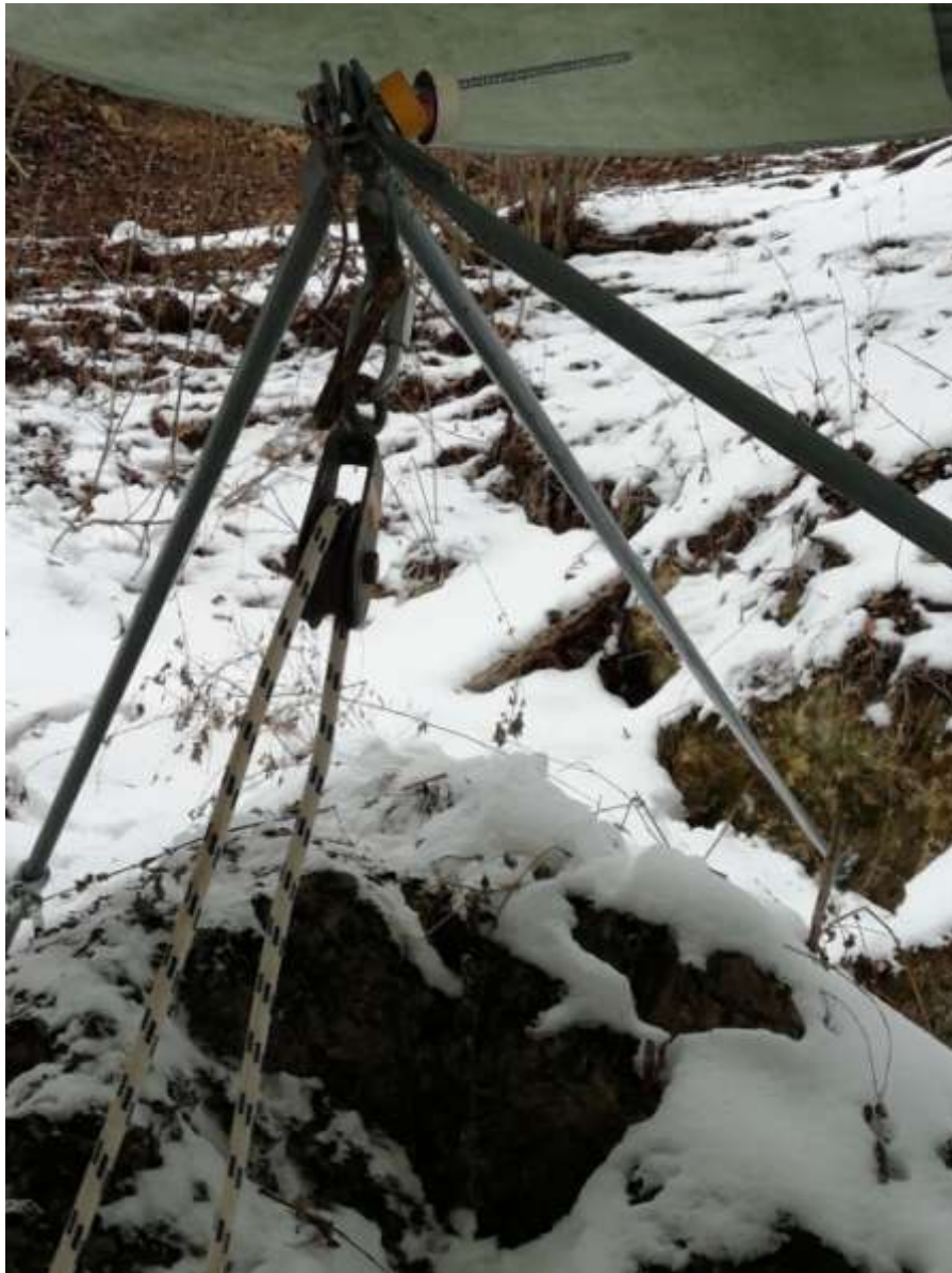
5. sz. fotó: Könnyen telepíthető 3 lábú kézcserlő-állvány az anyagmozgatás megkönnyítésére, a barlang bejáratában. (Fotó: Kocsis Gergely)
