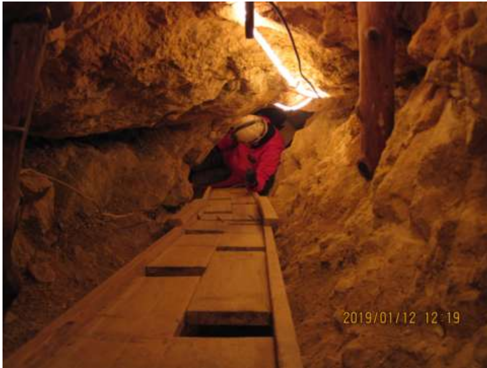
12. ábra: a „forduló” a legkeményebb munkahely: itt kell átemelni a végpontról érkező badellákat a 70°-os lejtésű „nagyakna” csúszdájára. Persze mindezt kényelmetlen testhelyzetben, kicsi helyen... (fotó: Stieber József)
