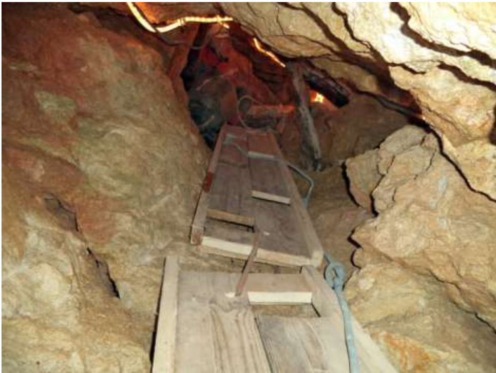
1. sz. fotó: A barlang 2016-ban, több részletben feltárt kisaknájában történő biztonságos mozgás érdekében gyorsan telepíthető, összeecsukható csúszdás-létrát használtunk, melyet műszak végén könnyedén tudtunk kiszállítani a barlangból (fotó: Kocsis Gergely)
