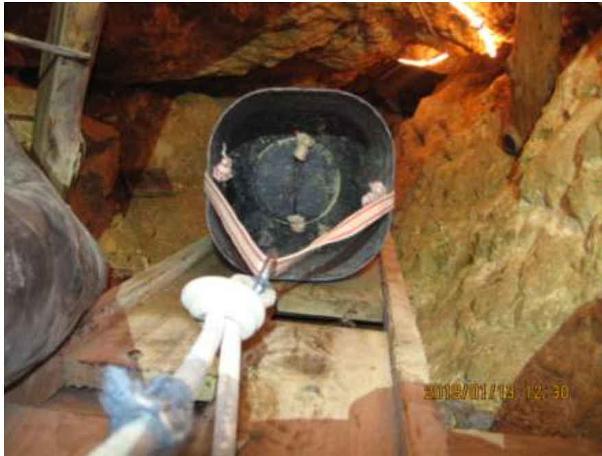
6. sz. fotó: Anyagmozgatás az ideiglenesen beépített, vörösfenyőből készült csúszdán. (Fotó: Stieber József)
