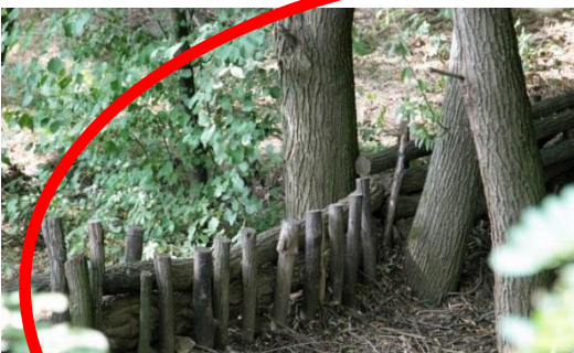
Lefolyáslassítás szivárgó rönkgátakkal
