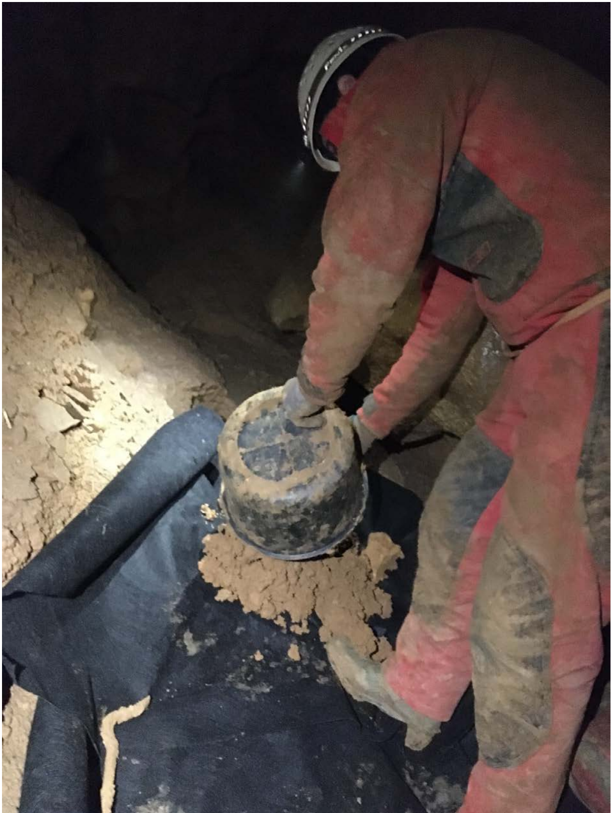
Geotextilre rakjuk a bontási törmeléket
