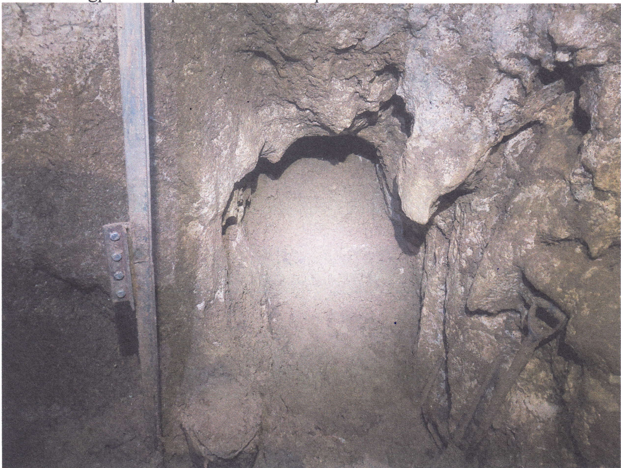
Kutatási végpont: 8. pont fel a kitöltés agyagmentes mosott kő
