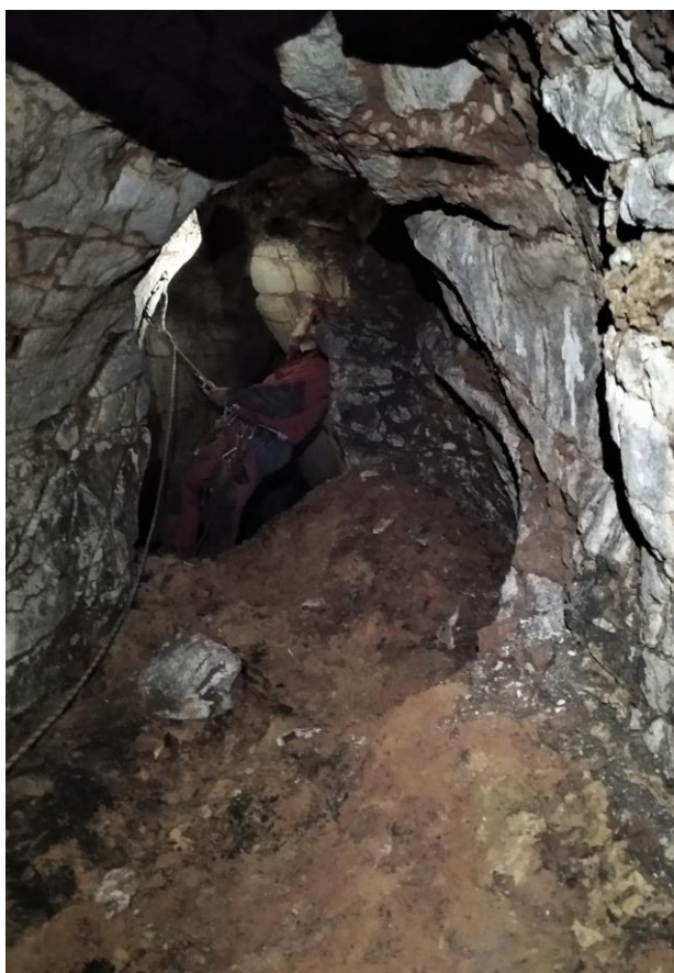
A Színpad feletti- és a Honfoglalás-kürtő közötti átjáró
