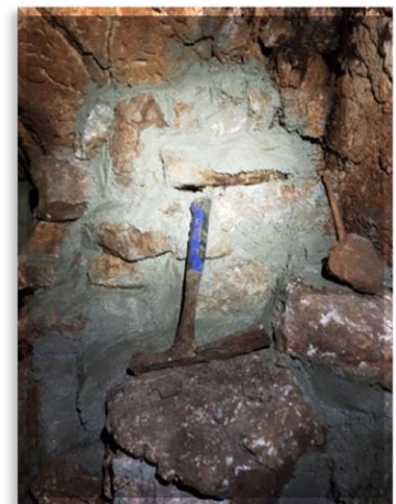
Falazat rései betonnal kitöltve
