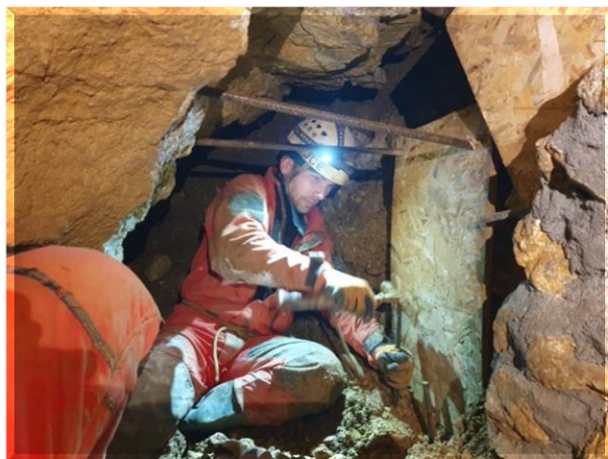
A fal végső szakaszán OSB lapokat helyez el Joe zsaluzás céljából
