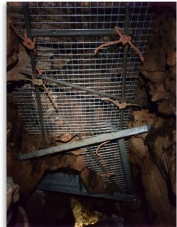
A főte biztosítása vasakkal és betonhálójával
