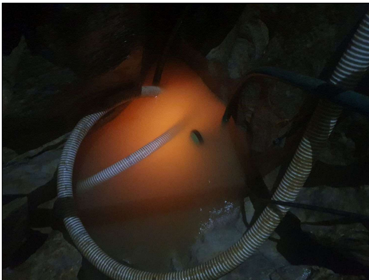
2. fotó. A szifon belülről megvilágítva
