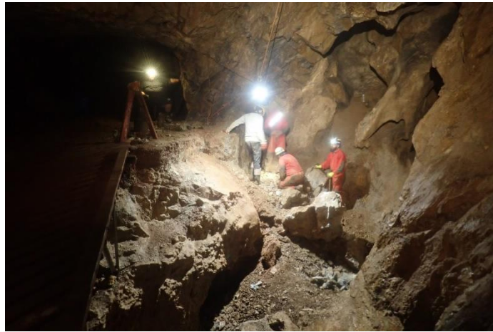
A Gömbüstökös oldalában kimozduló kövek elbontása
