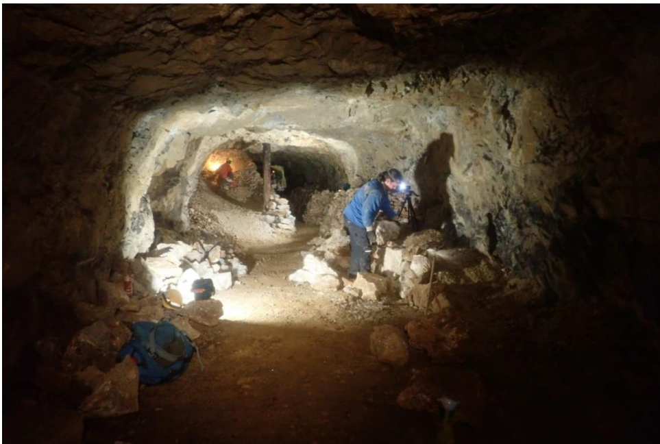
A Hármás múzeum építése
