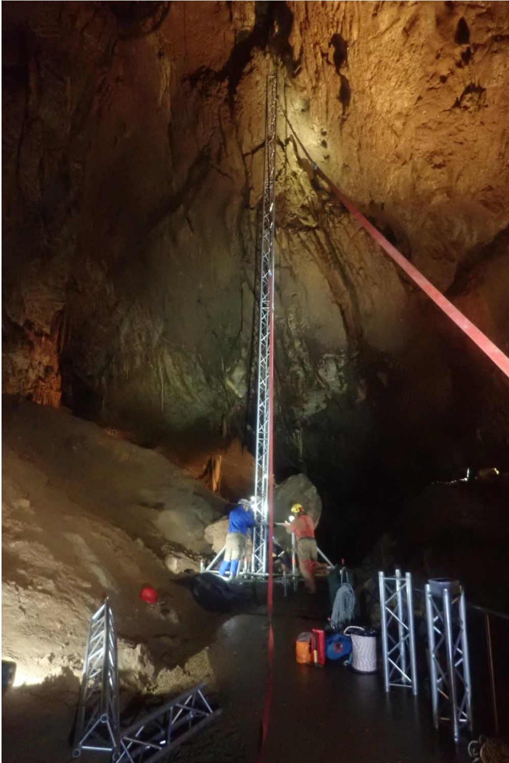
Állvány építése a „Bal pitvarnál”
