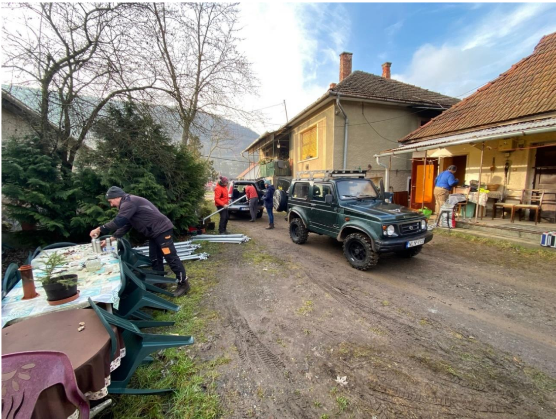
Előkészületek a Garan vendégház udvarán. A híd építéséhez szükséges alkatrészeket két terepjáróval szállítottuk fel az Esztramos bányaudvarába
