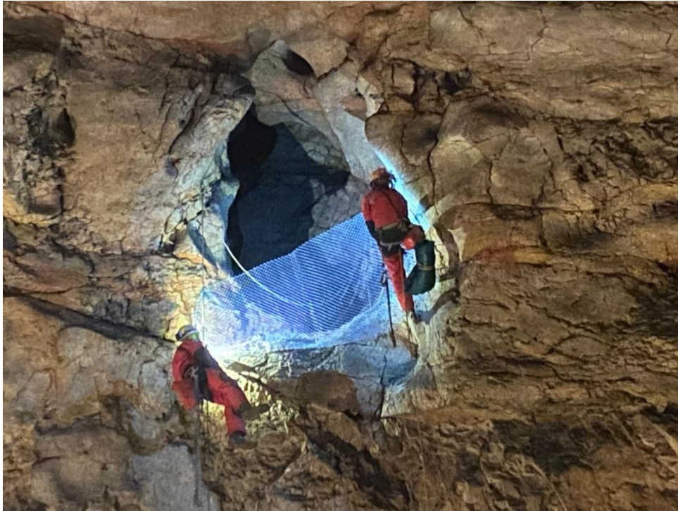
A rozsdamentes acélháló felerősítése a kürtő bejáratánál
