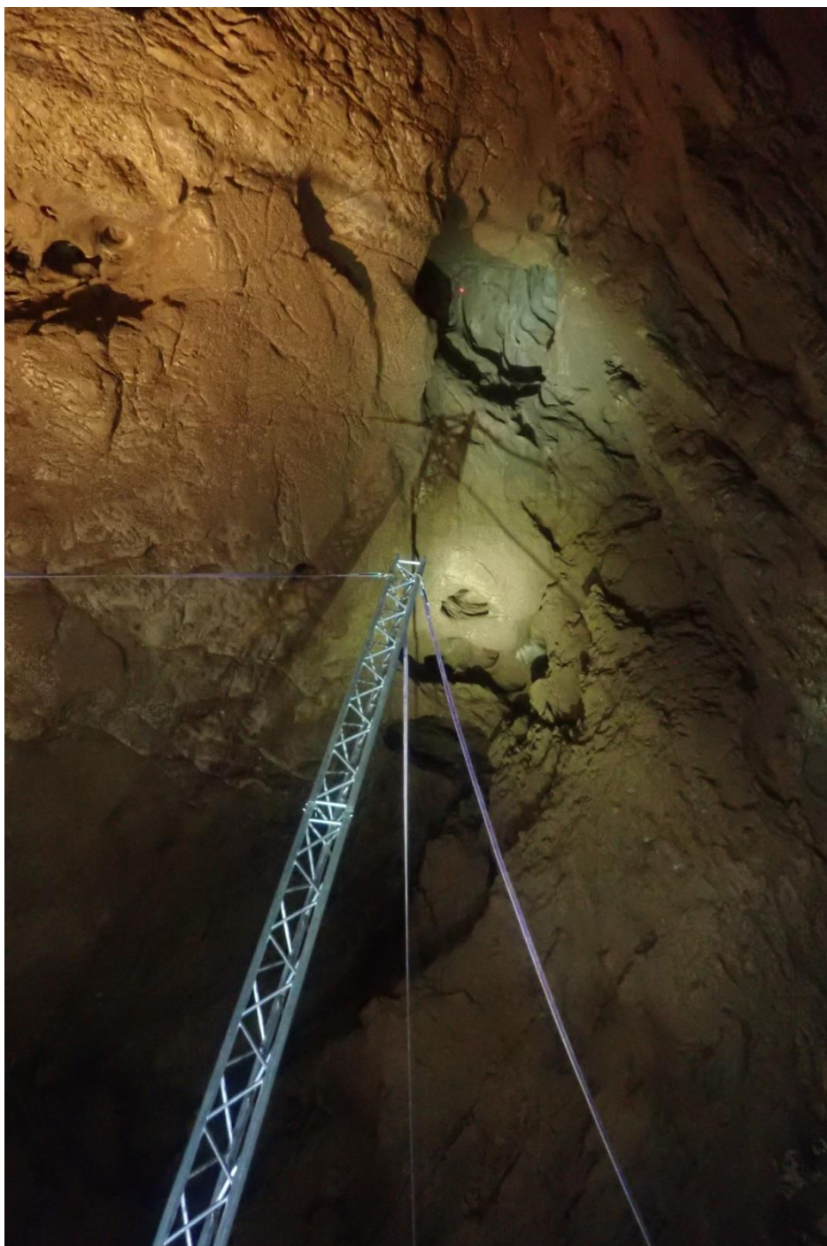
A Jobb pitvar elnevezésű kürtő állványozása
