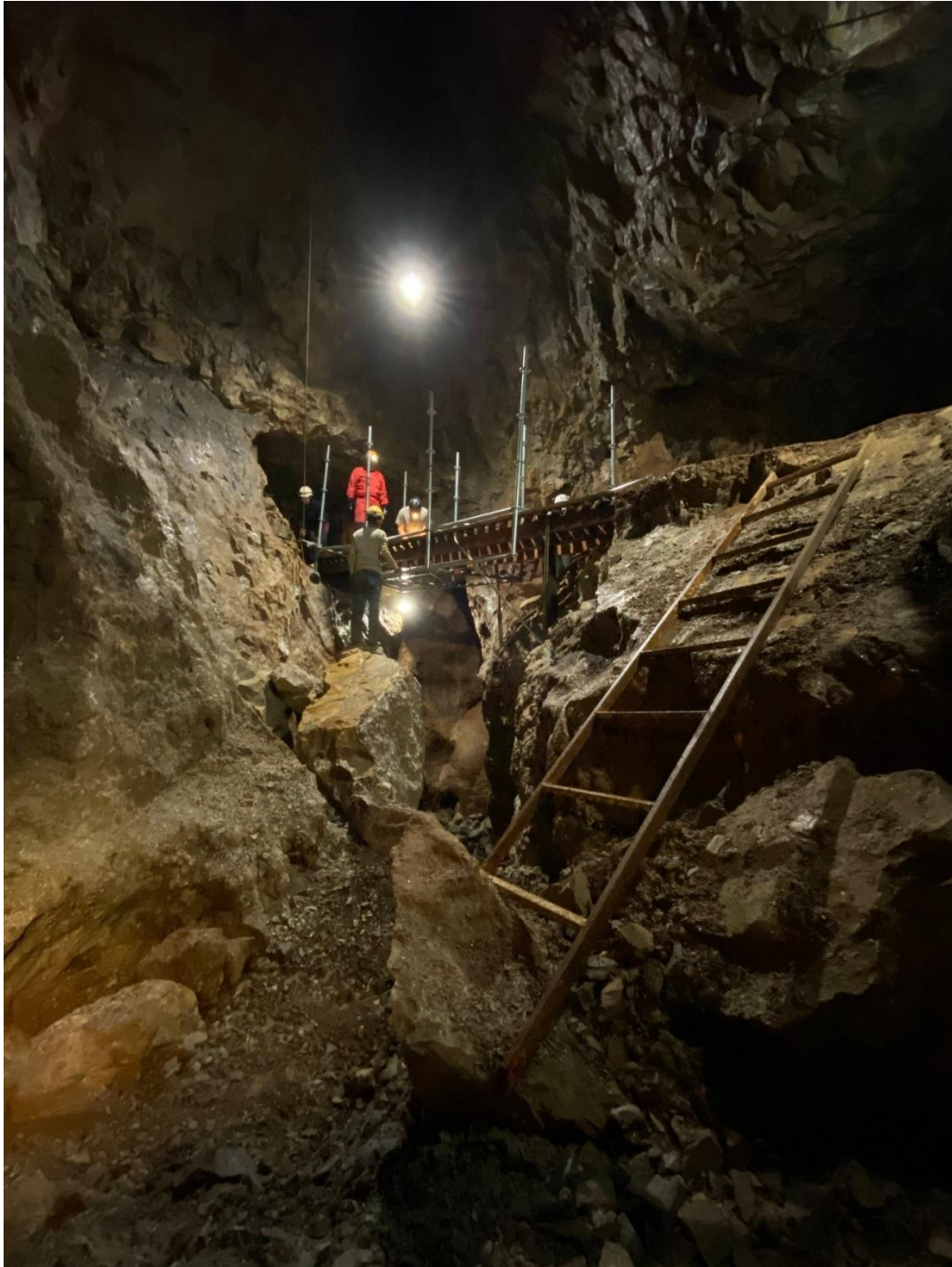
A híd megerősítésének kezdeti lépései
