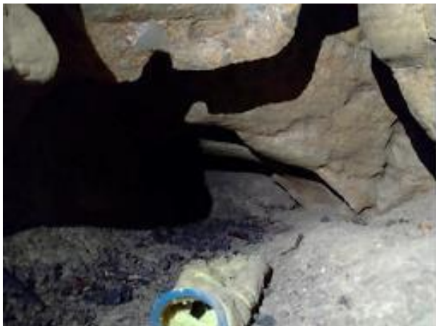
Itt kezdődött a kuszoda bontása
