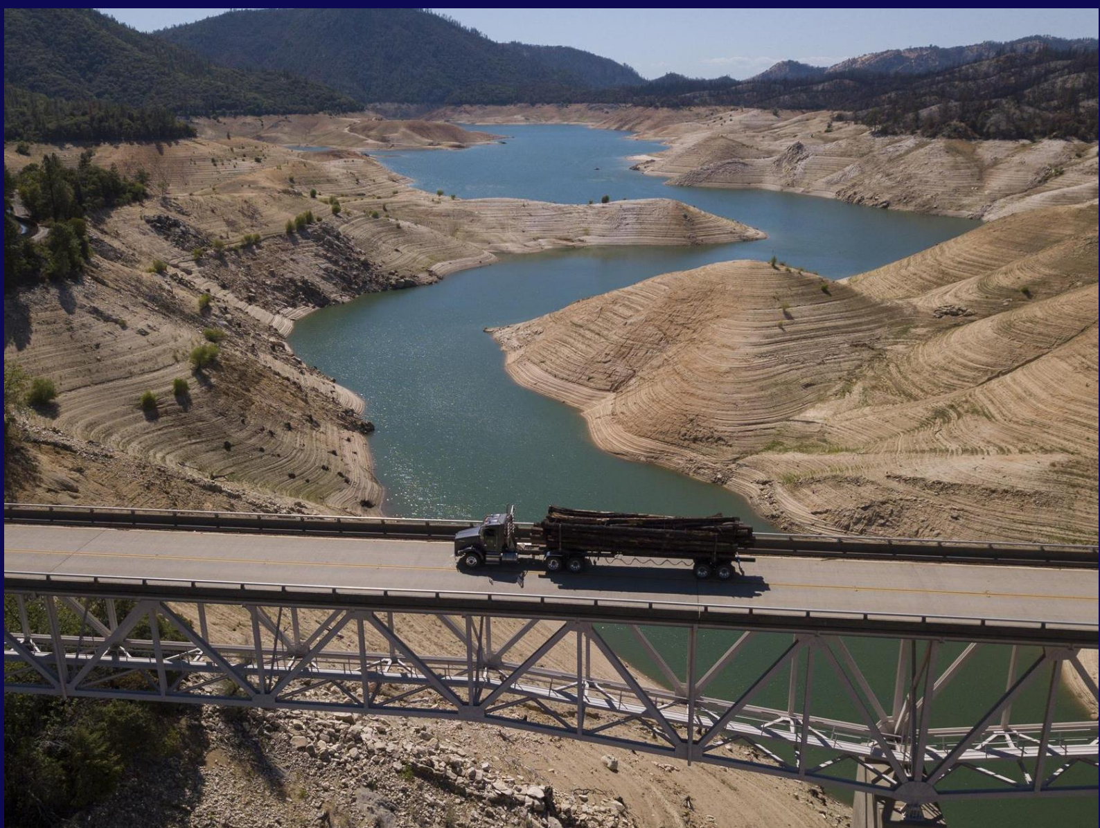
Oroville-gát, Kalifornia, USA
