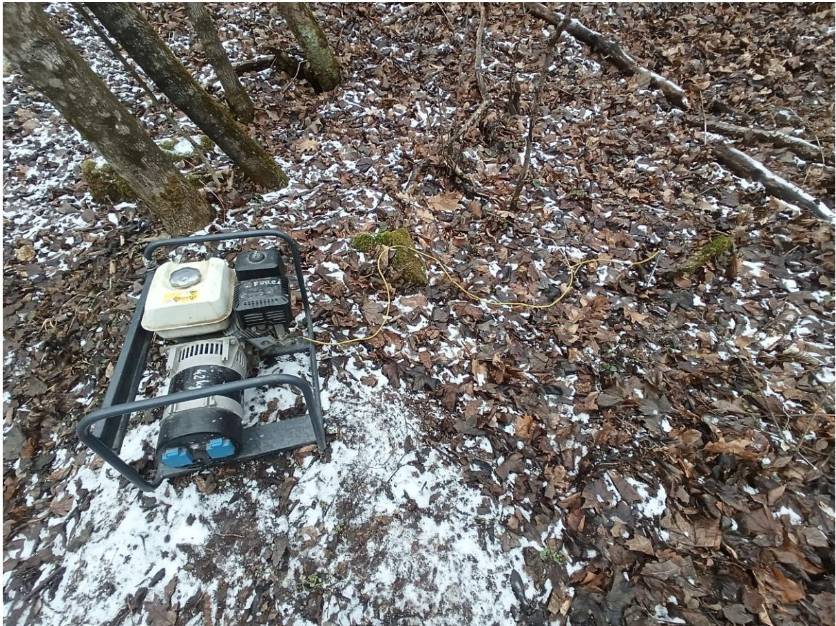
7.a Ideiglenesen telepített aggregátor és a földelés kialakítása (képek: Kocsis Gergely)
