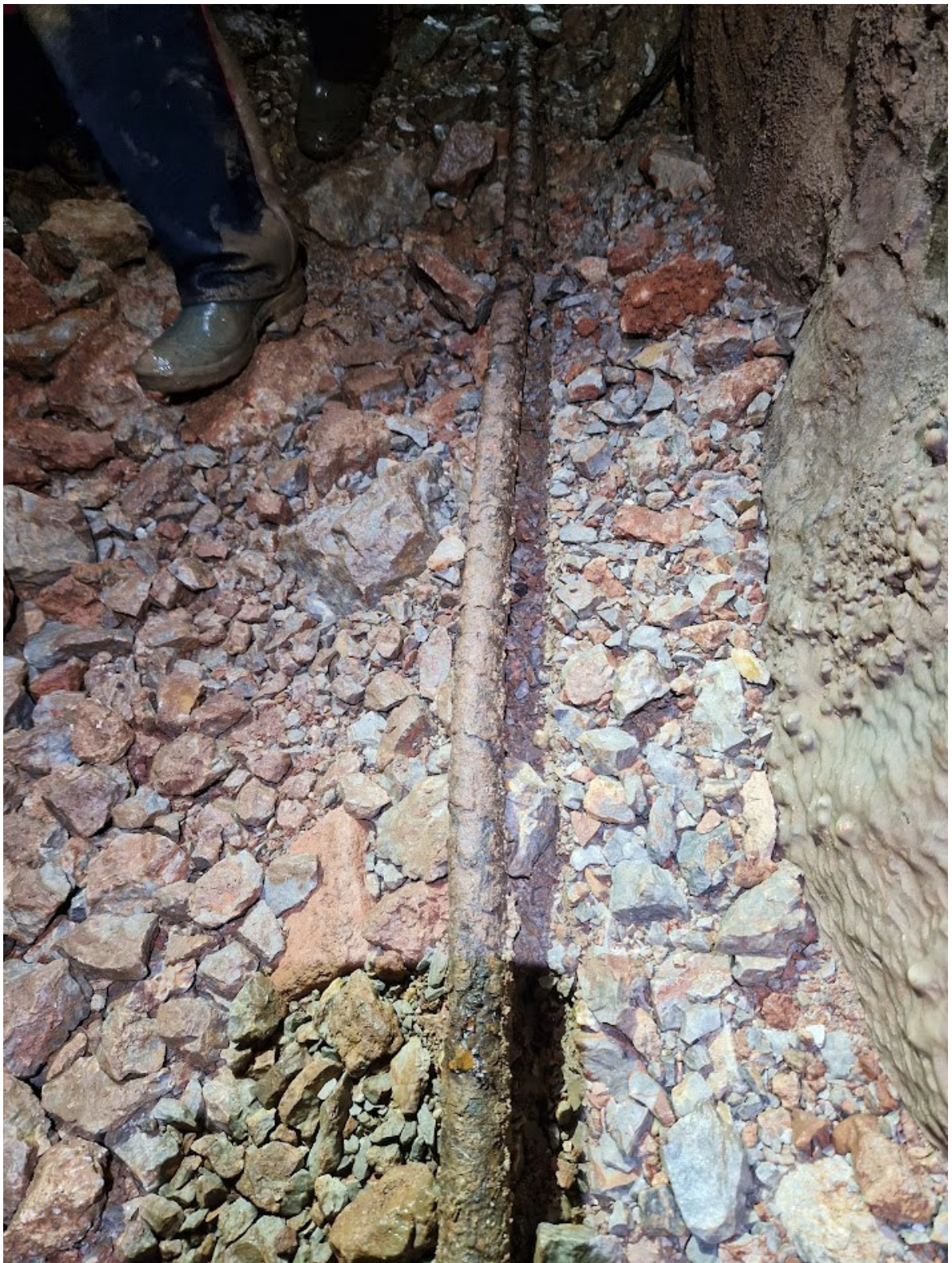
2. kép: Az egykori erősáramú kábelvezeték egy szakasza a bejárat közelében
