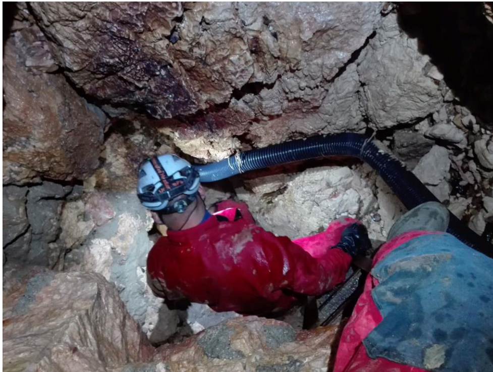
A gégecső friss levegőt szállít a bontási helyre (fotó: Szarka Róbert)
