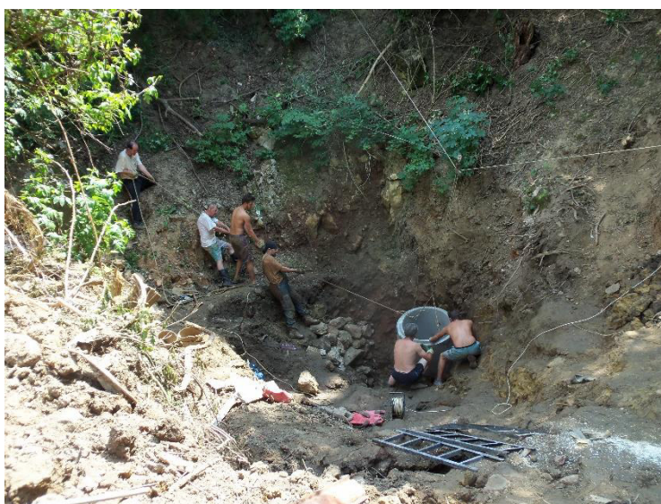
A kútgyűrűk beemelése húzórendszer segítségével (fotó: Farkas Andrea)
