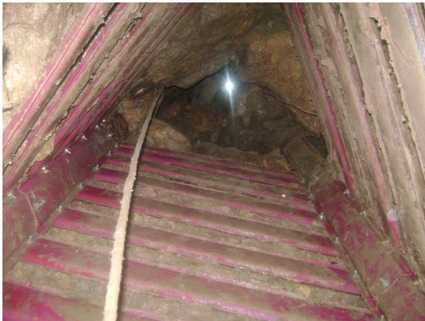
Felületkezelt acél ácsolat a kritikus szakaszon (fotó: Szalay Jenő)
