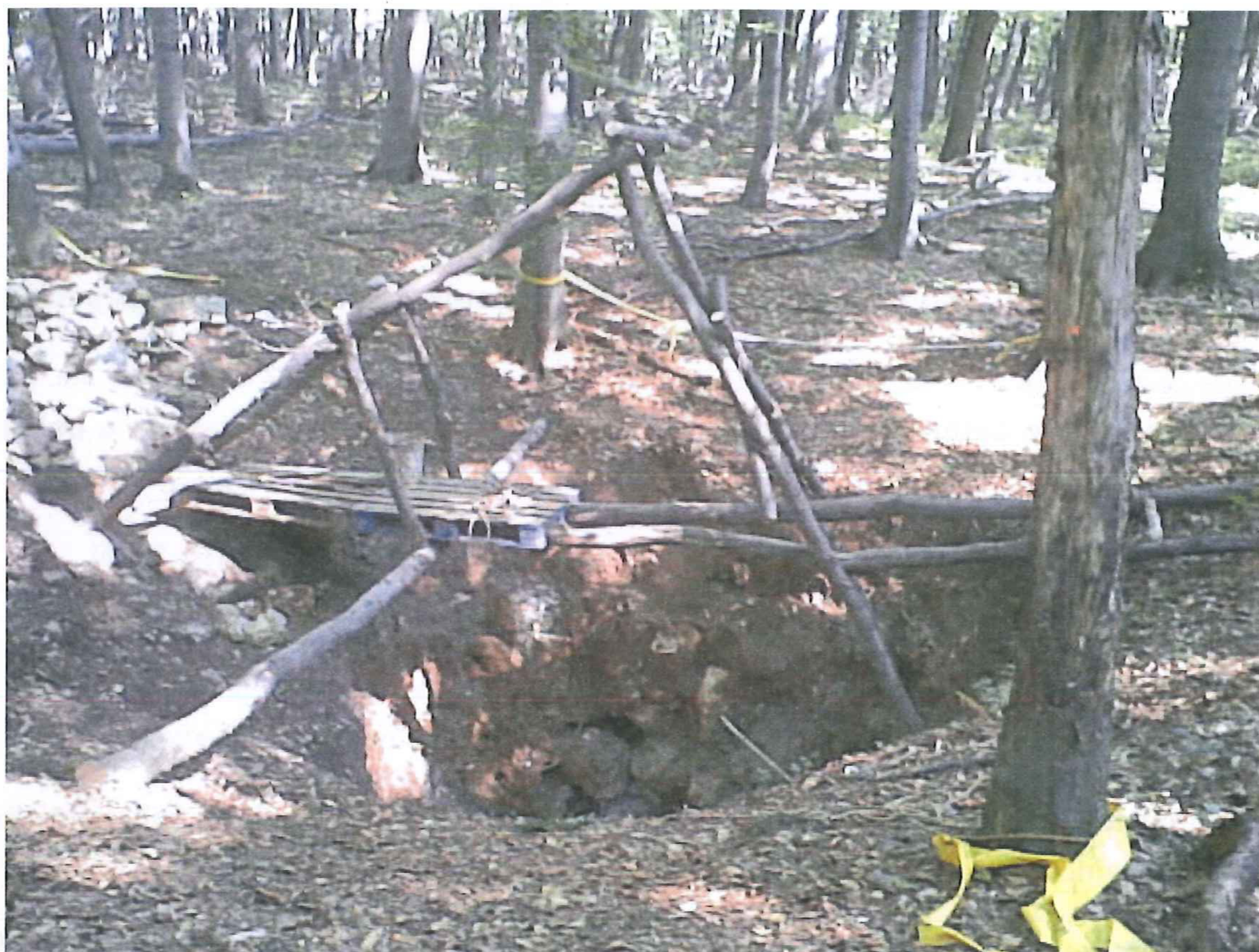
1. ábra Küzdelem-barlang bontási ácsolat
