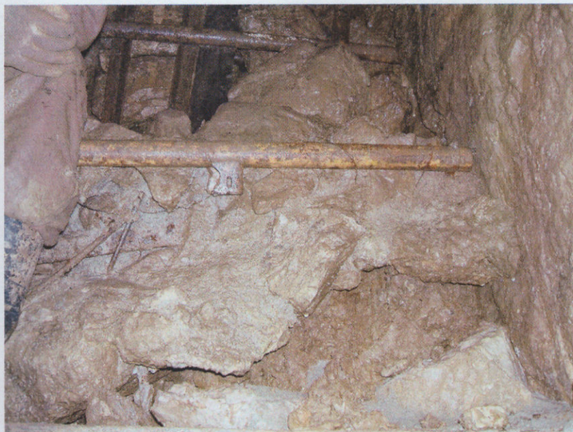
2, (9.kép) beton + rakott terméskő ferde egy betonnal tartja a föld 7 m-t megint ástak, ott a fa fémrúddal rögzítve megint bontás, habarccsal összefogott, hogy legyen mi mögé depózni
