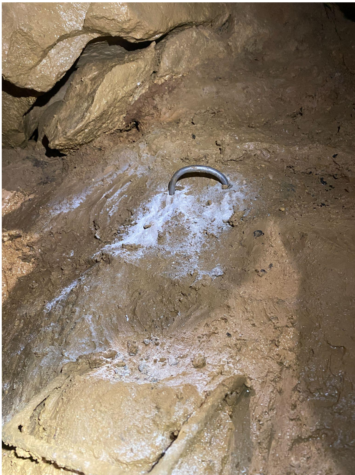
Régi elhajlott, elrozsdált lépőfok lenn és új, rozsdamentes lépőfok fenn
