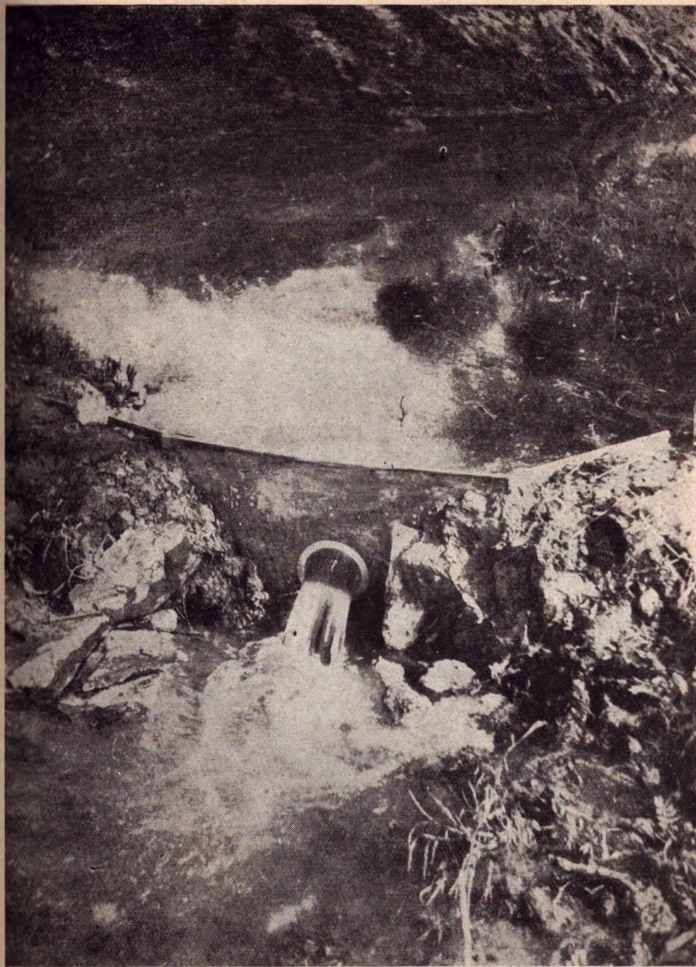
A karsztforrások mérésére alkalmazott hordozható Kessler-féle mérőlap. — Tragbare Messplatte Kesslers zur Messung der Karstquellenschüttung. (Foto: Kessler H.)
