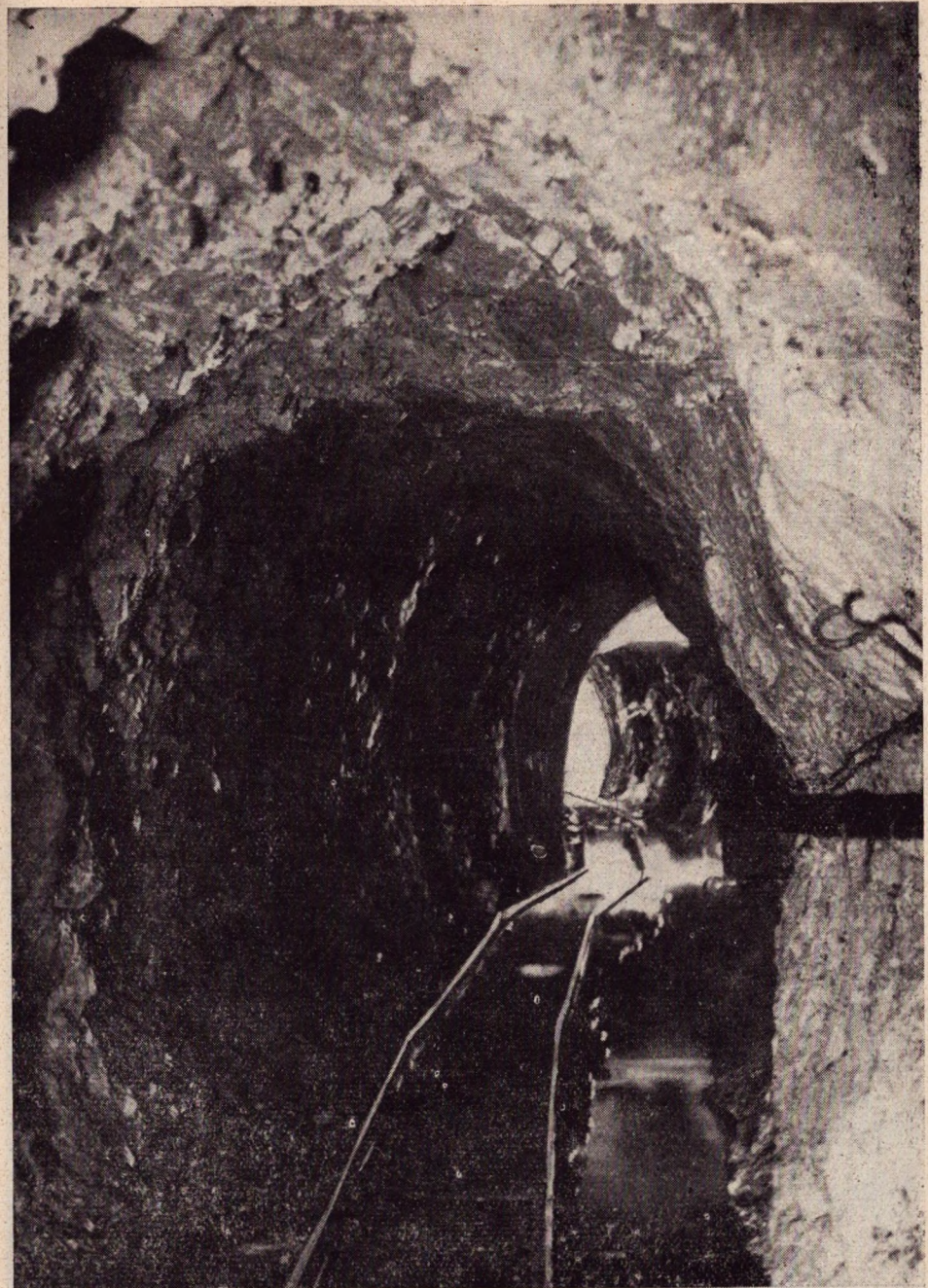
A pécsei tettyei karsztvízkutató akna ki nem épített oldalvágata. — Der noch nicht ausgebaute Seitenlauf des pécscher Karstschachtes am Tettye. (Foto: Kevi L.)
