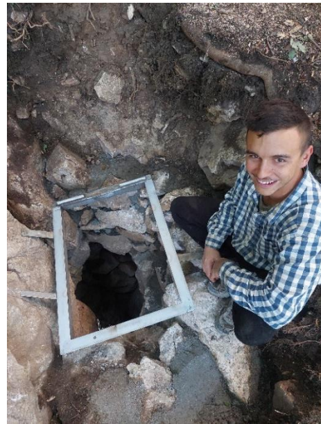
3. ábra A helyi anyagból készült aláfalazás.
