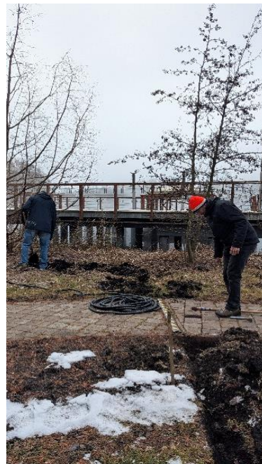
Talajnedvességmérők telepítése, felújítása, tápkábel cseréje
