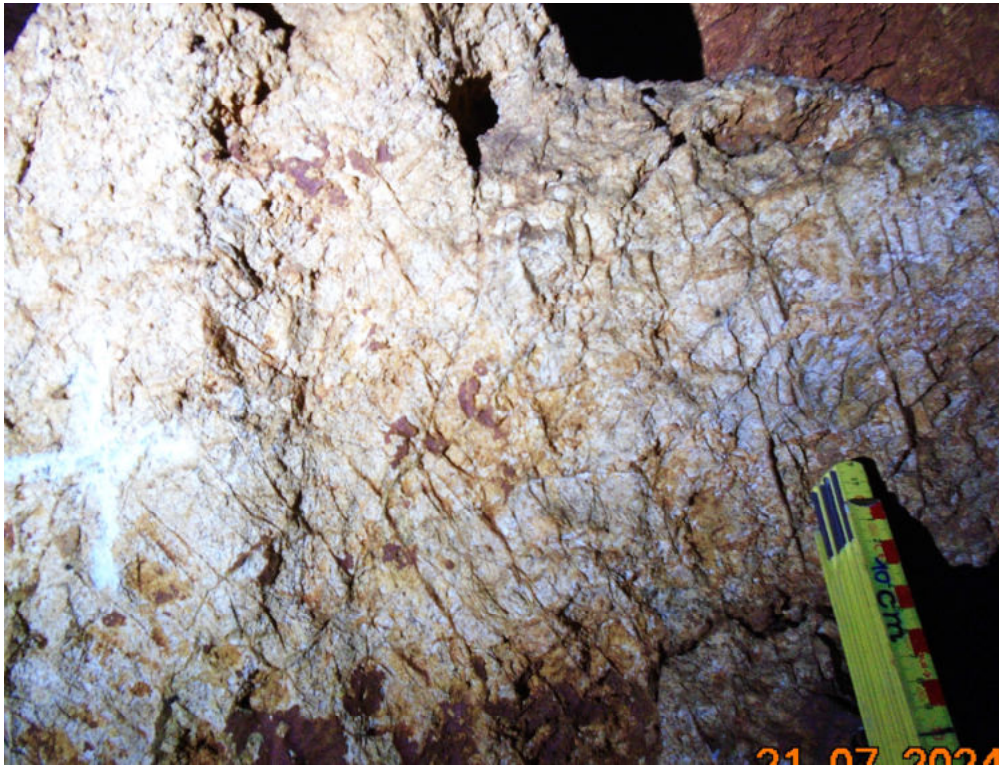
8. kép Dobozszerkezetes kőzetmállás
