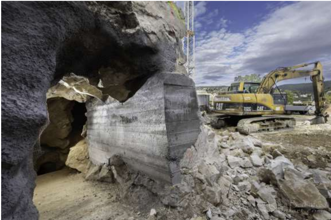
6. fénykép. A betonfallal megtámasztott új bejárat.
