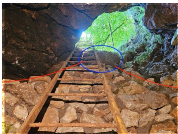
Az épülő fal (b) és a kész fal (j) ideiglenesen betámasztott létrával. A jobb oldali képen látható a megtámasztott kő, piros vonalak a fal peremét mutatják. (Fotó: Mészáros József)
